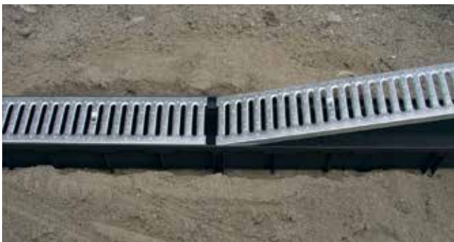
Appoggiare le griglie sui canali La lunghezza delle griglie in metallo è 997 \pm 1 mm per evitare problematiche di dilatazione lineare
