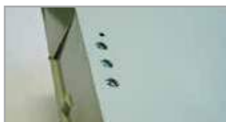
Fori sul fondo per impedire la formazione del ghiaccio
