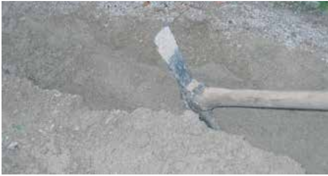
Realizzare una traccia nel terreno 10 cm più larga e 5 cm più fonda dei canali da posare
