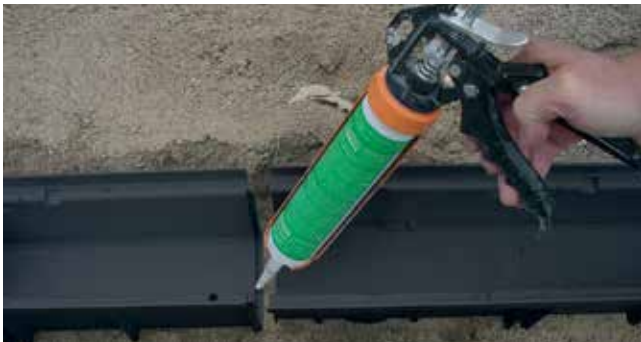
Utilizzare un normale sigillante siliconico per unire i canali fra loro
