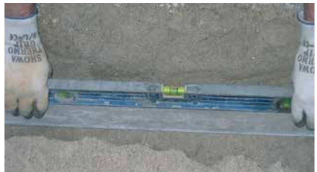
Stendere un letto di cemento a profondità del canale, facendo attenzione a non dare alcuna pendenza
