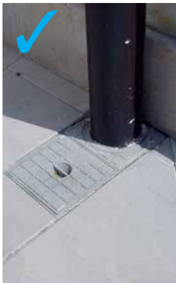
Pozzetto pluviale corretta installazione
