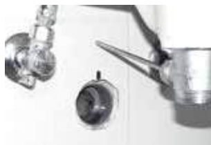
1) smontaggio del sifone esistente
