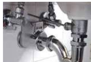
6) montaggio del sifone e armonia estetica finale
