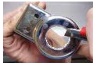
4) adattamento della rosetta cromata (d. 1"1/4 e 1"1/2 prefondato)
