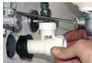
2) inserimento del corpo valvola con guarnizione tecnica montata
