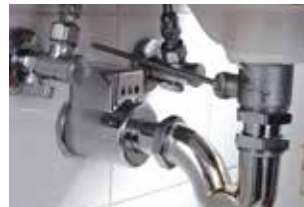
6) montaggio del sifone e armonia estetica finale
