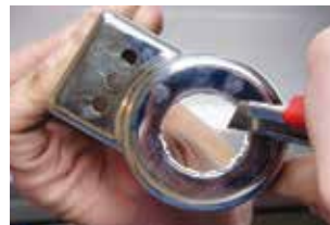
4) adattamento della rosetta cromata (d. 1"1/4 e 1"1/2 presfondato)
