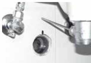
1) smontaggio del sifone esistente
