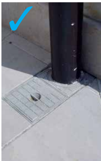
Pozzetto pluviale corretta installazione
