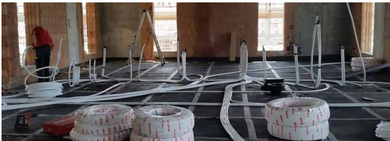
Installazione del sistema di adduzione acqua sanitaria Nicoll Fluxo
